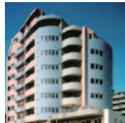
5 西葛西グリーンホームズ RC造地上10階建 52戸 2003年8月竣工
