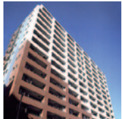
9 葛西駅前グリーンホームズ SRC造地上15階建 99戸 2004年12月竣工
