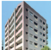
6 南葛西グリーンホームズIII RC造地上9階建 22戸 2004年8月竣工
