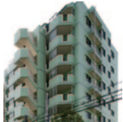
16 中葛西グリーンホームズII RC造地上9階建 24戸 2008年3月竣工
