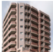
17 中葛西グリーンホームズIII RC造地上10階建 52戸 2008年9月竣工
