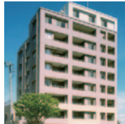
4 葛西南グリーンホームズ RC造地上9階建 21戸 2003年4月竣工
