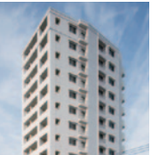
14 中葛西グリーンホームズ RC造地上15階建 37戸 2007年3月竣工
